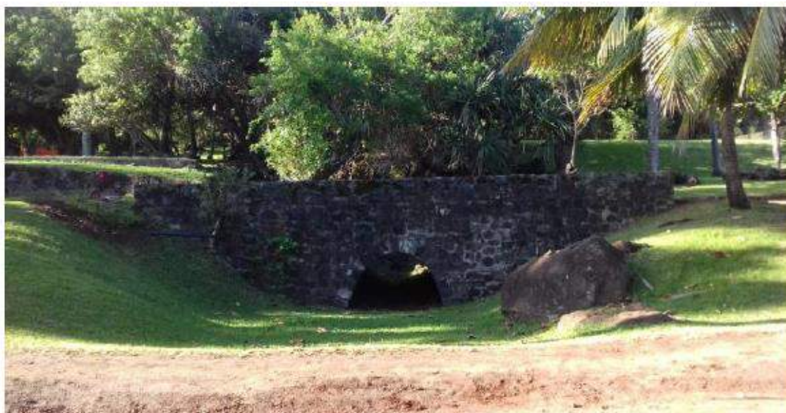
Figure 234: Vue du ponceau sur la petite ravine
