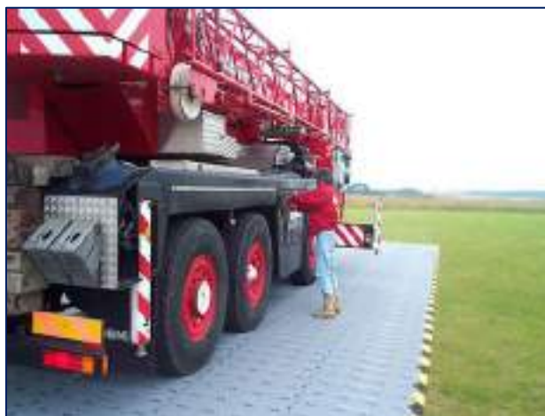
Figure 239 – Exemple de bande de roulement provisoire sans matériaux d'apport
