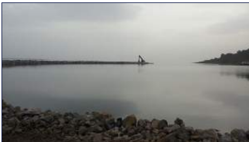
Figure 51 – Exemple de réalisation d'un enrochement à l'avancement
