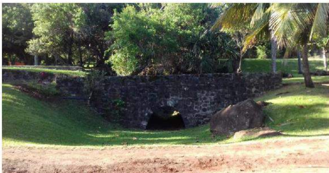
Figure 24: Vue du ponceau sur la petite ravine
