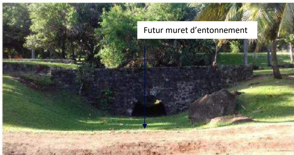
Figure 192: Position du futur muret d'entonnement
