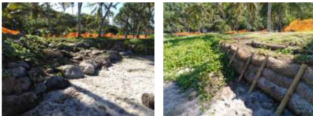
Figure 7: Clichés des boudins cocos et enrochements libres dans le cadre du chantier de l'arrière-plage
