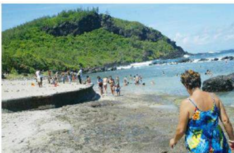
Figure 23: Photographie du muret au droit du bassin de baignade.
