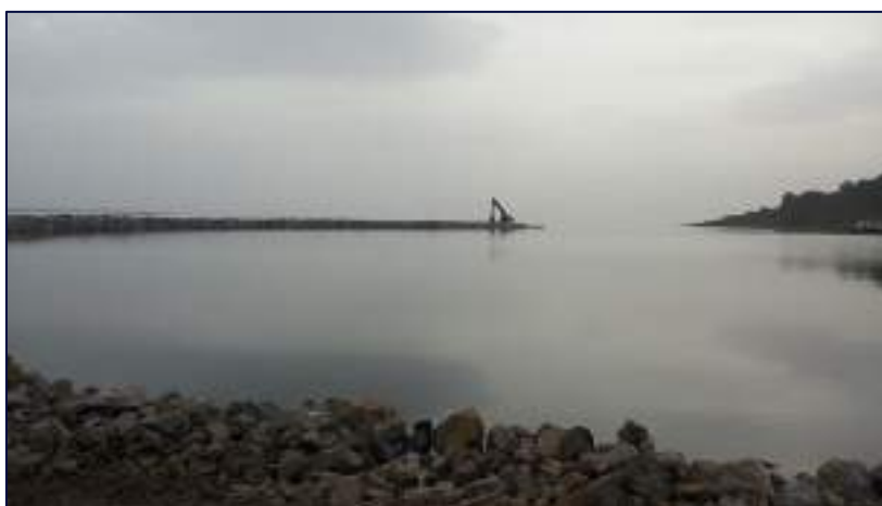
Figure 238 – Exemple de réalisation d'un enrochement à l'avancement
