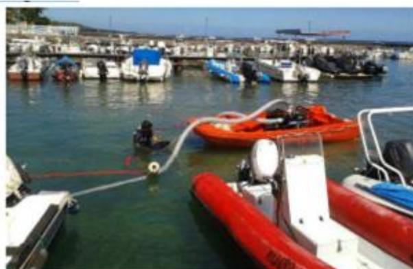
Figure 242 : Exemple de dragage hydraulique en situation de faible tirant d'eau dans le port de Saint Leu
