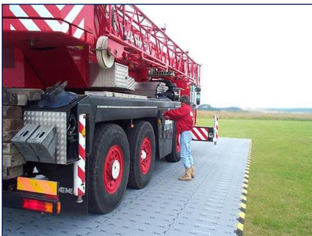
Figure 52 – Exemple de bande de roulement provisoire sans matériaux d'apport
