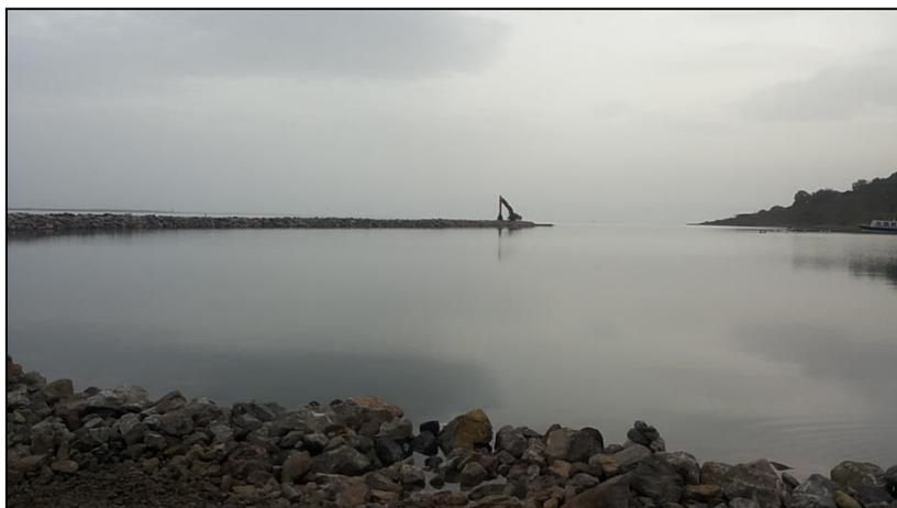
Figure 51 – Exemple de réalisation d'un enrochement à l'avancement
