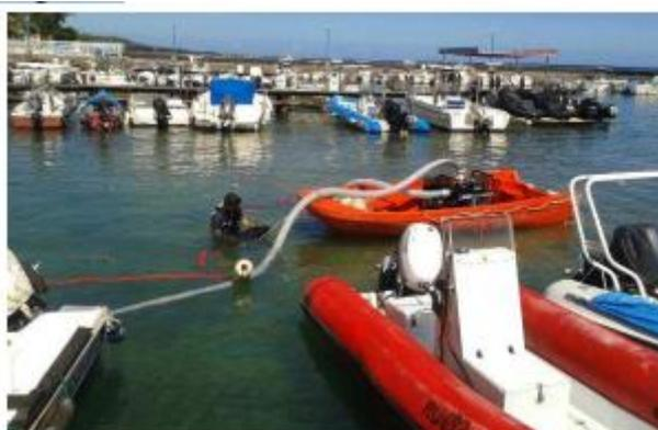
Figure 12: Exemple de dragage hydraulique en situation de faible tirant d'eau dans le port de Saint Leu.
