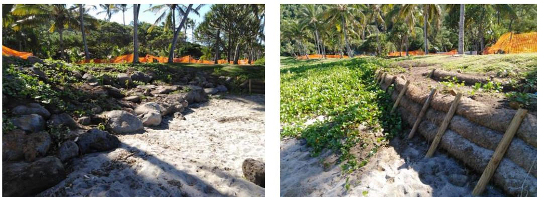
**Figure 1: Clichés des boudins cocos et enrochements libres dans le cadre du chantier de l'arrière-plage**
