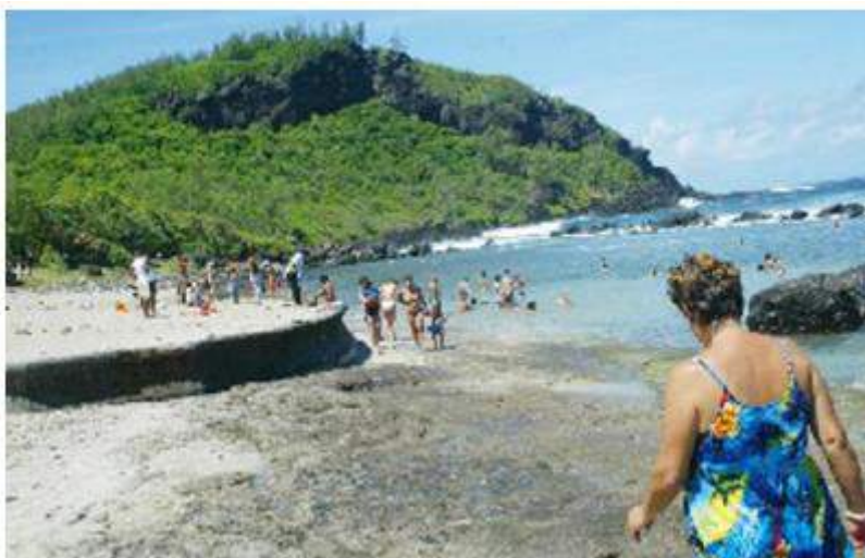
Figure 40: Photographie du muret au droit du bassin de baignade.
