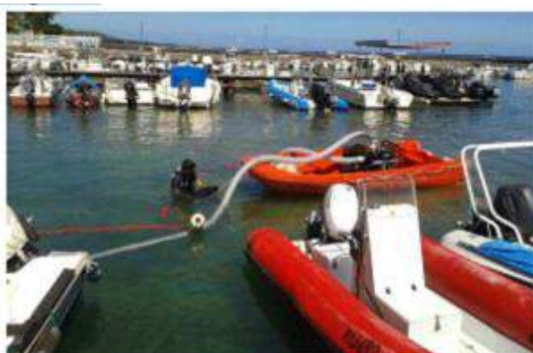
Figure 58 : Exemple de dragage hydraulique en situation de faible tirant d'eau dans le port de Saint Leu
