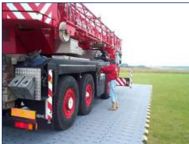
Figure 180 – Exemple de bande de roulement provisoire sans matériaux d'apport
