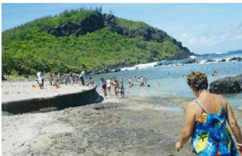
Figure 233: Photographie du muret au droit du bassin de baignade.
