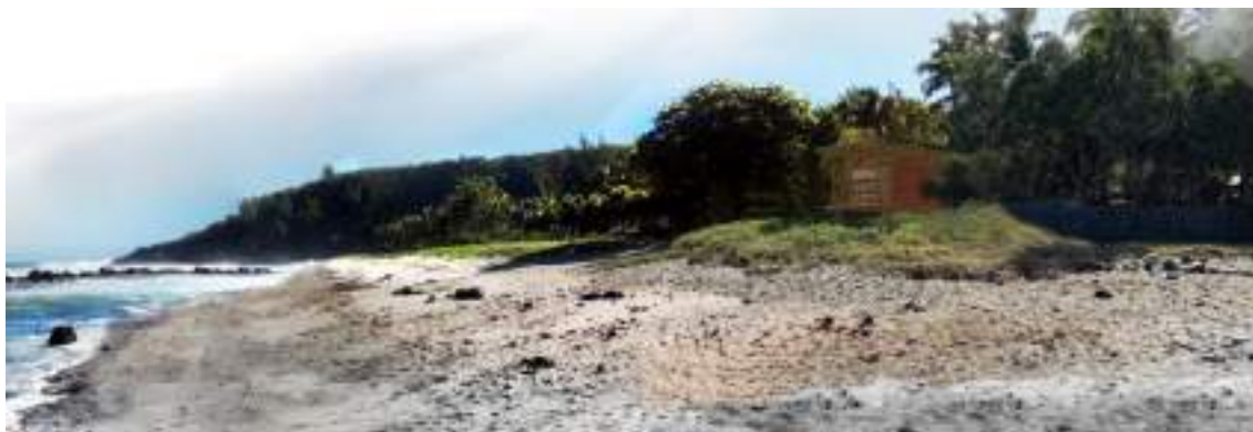
Figure 32: Vue panoramique sur le futur talus végétalisé au pied du local de surveillance
