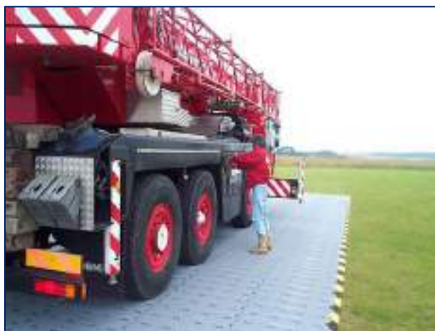
Figure 52 – Exemple de bande de roulement provisoire sans matériaux d'apport
