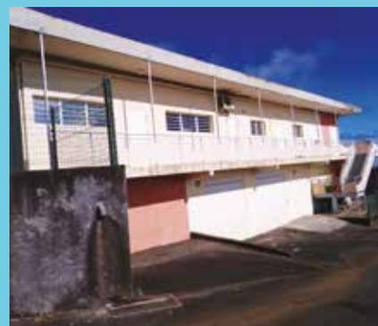
**L'objectif premier de l'opération est de stopper les dégradations structurelles des trois bâtiments (étanchéité, épaufrement, éclairage...)**
